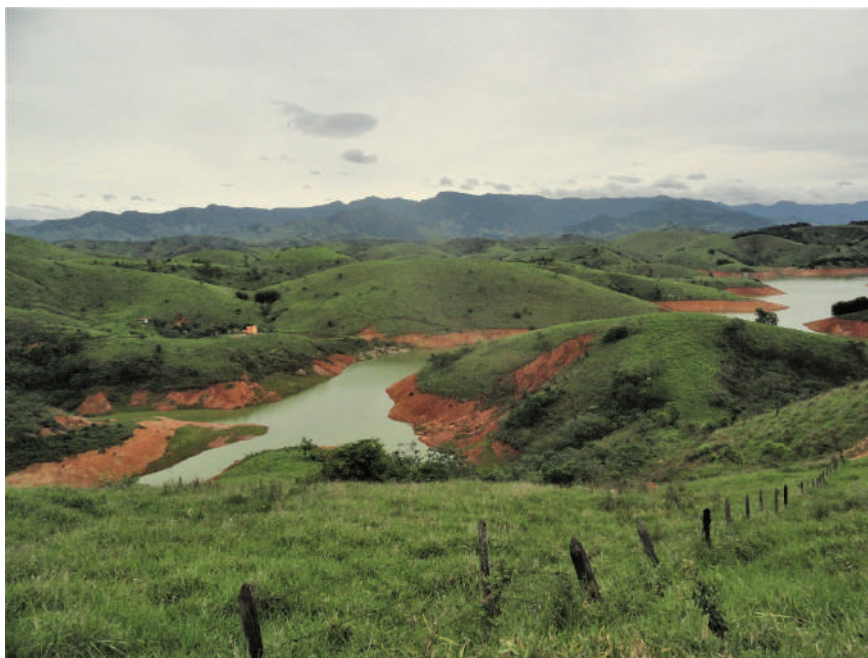
Figura 2 – Visão geral dos principais domínios geomorfológicos no médio vale do rio Paraíba do Sul. Em primeiro plano, o domínio colinoso representado pelo típico relevo de mar de morros; ao fundo, o domínio serrano, representado pelas vertentes íngremes e escarpadas do flanco norte da Serra da Bocaina. Represa do Funil (Itatiaia/RJ). Foto: Marcelo Dantas.
