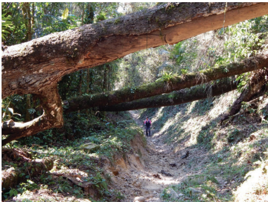
Figura 5 – Evidências erosivas do uso intenso por muares no antigo caminho da Cesárea. Foto: Adi Lazos.
