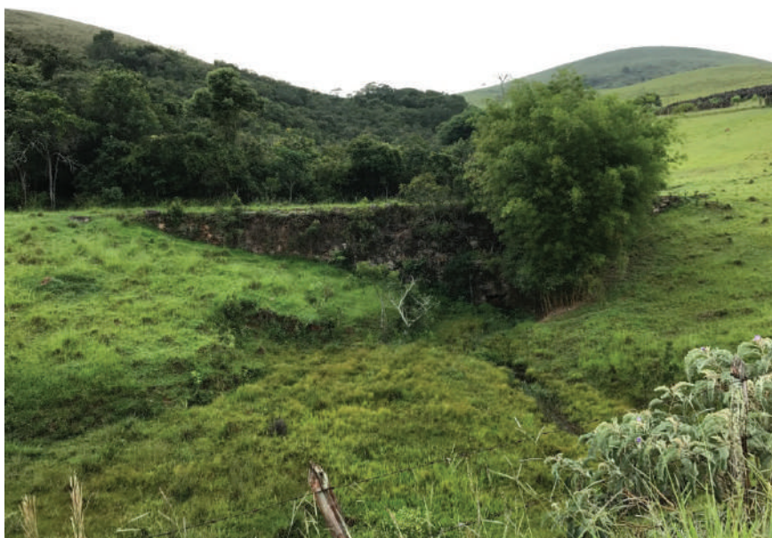
Figura 4 – Ponte de estrada do século XIX. São Vicente de Minas (MG). Foto: Rogério R. Oliveira.
