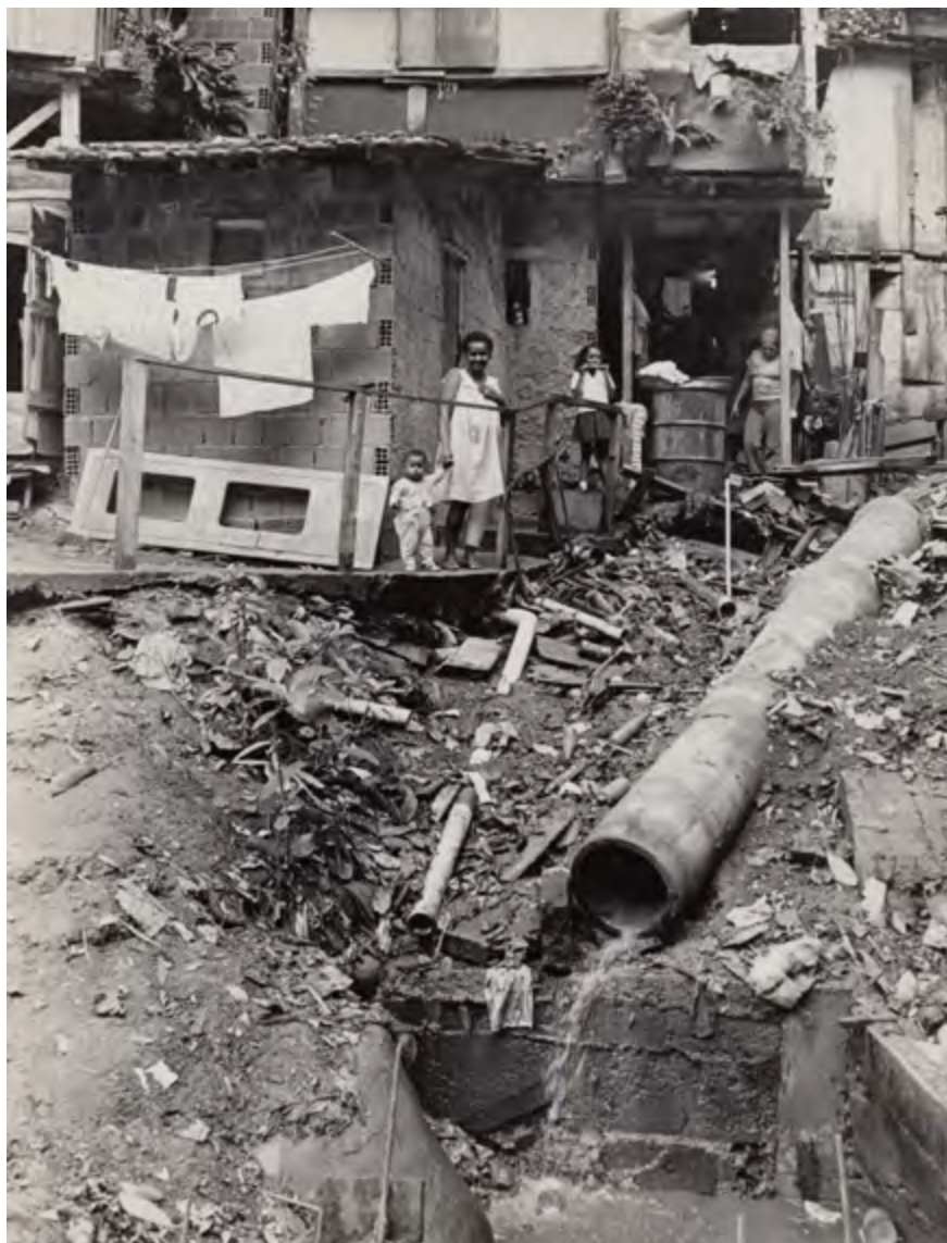
Tubulação de esgoto, Início dos anos 1980.
