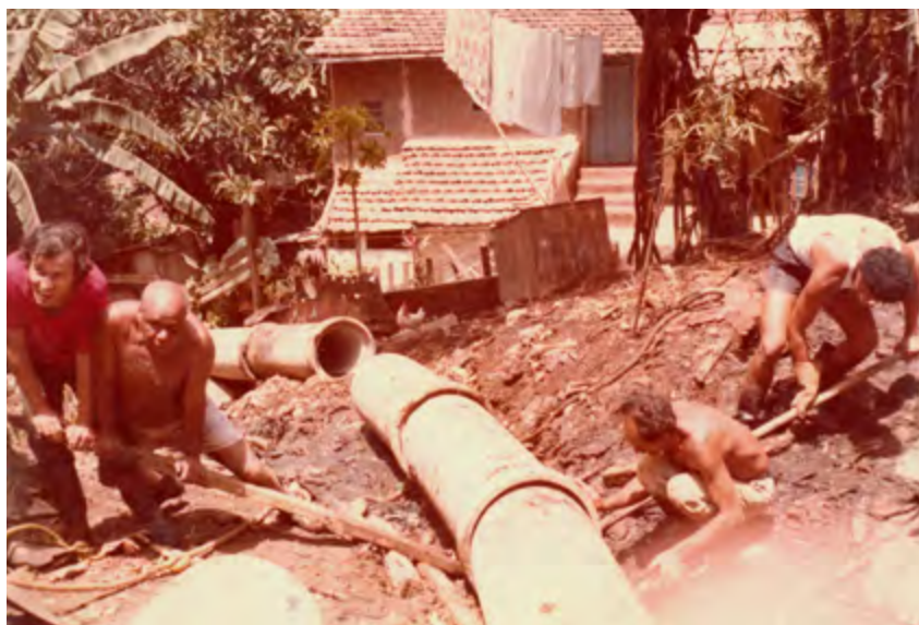
Obras de canalização do esgoto em mutirão, final dos anos 1970.
