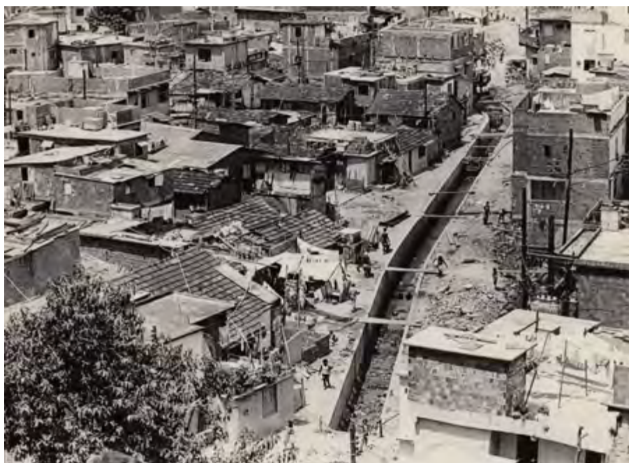
Obra de saneamento do valão, início dos anos 1980.
