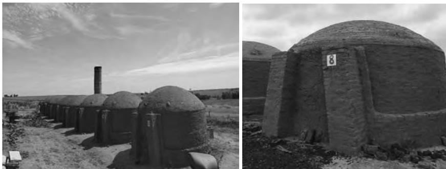
**Figura 3.20** – Fornos de alvenaria (Carvoaria Festeiro).
