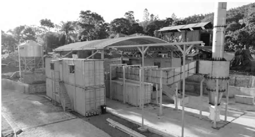
**Figura 3.17** – Pirolisador em larga escala (NetZero).
