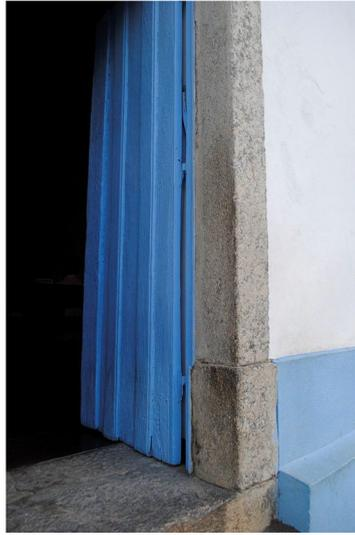
Figura 1: Detalhe de um pórtico de construção do século XVII no Rio de Janeiro feito em gnaiss facoidal.
