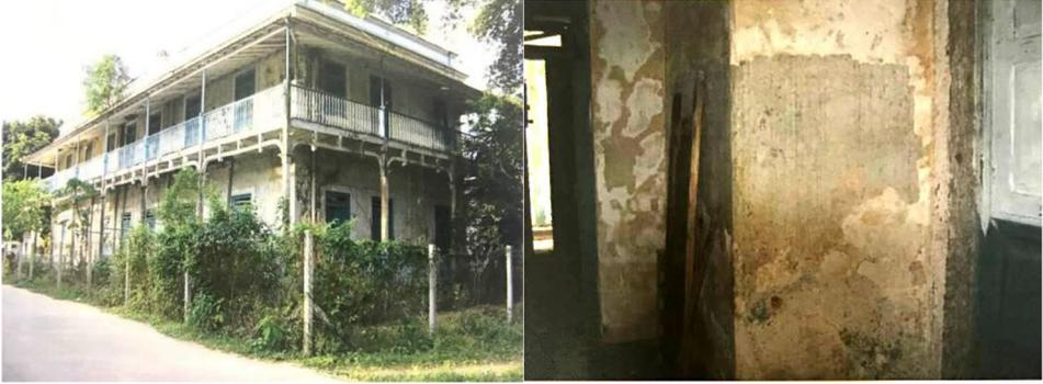
Figuras 11 e 12: À esquerda, visão da fachada da antiga sede do *Engenho Novo da Taquara* descaracterizada por reformas. À direita, visão interna. Note as ombreiras afuniladas nos vãos, e as paredes com 1 m de espessura. Fotos: T.A. Lima. Fonte: Lima, 2011b.
